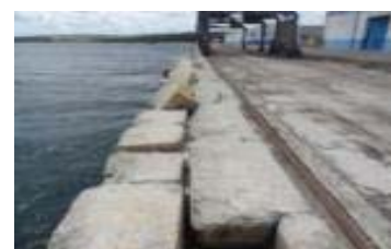
老朽化が著しい北埠頭の写真
