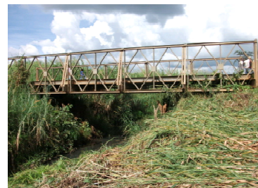
現行の仮設橋
