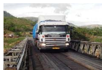
一車線のみ現行の橋
