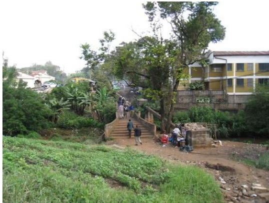
未接続区間の状況
