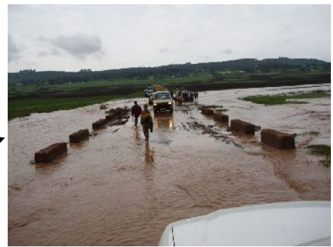
現況：冠水する道路
