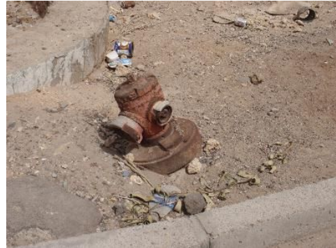
故障した消火栓
