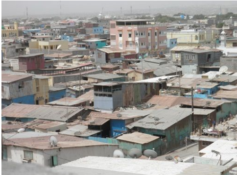
延焼危険の高い木造トタン張り家屋の密集地帯
