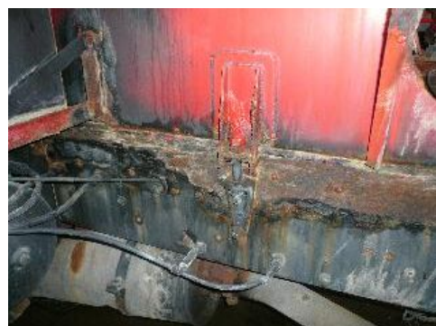
腐食した水槽車のシャシフレーム
