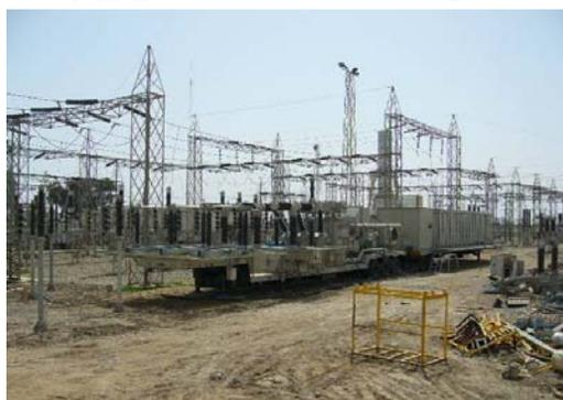
据付完了した移動式変電設備
