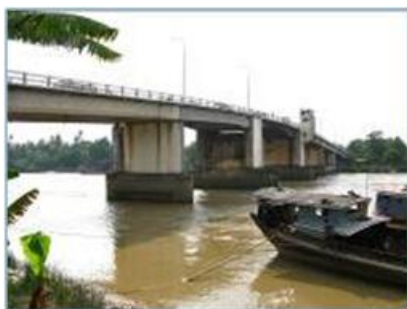
写真1 既存タケタ橋の概況
