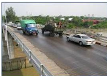
写真2 既存タケタ橋の交通状況
