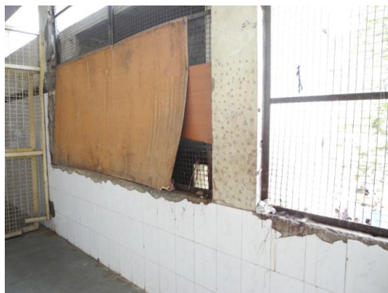
② 階段踊り場の壁の補修状態
