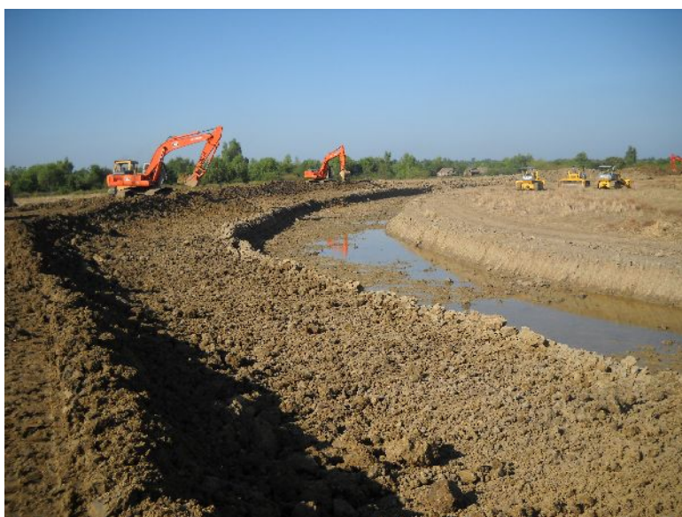
(写真2) 輪中堤復旧工事の状況（開発調査での実証事業）
