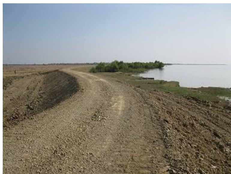
(写真3) 輪中堤修復工事（実証事業）完了後
