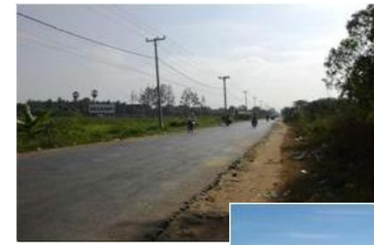
改修前 【参考】第3期区間
