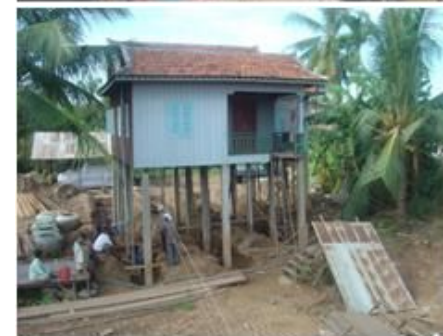
セットバック後の建物
