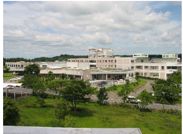
涌谷町町民医療福祉センター
