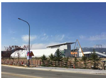
当時建設中の平昌メインスタジアム
