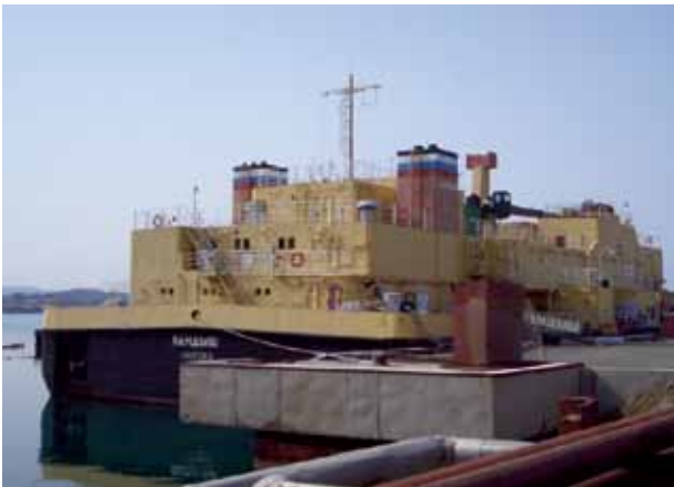
日露非核化協力事業で建設・供与された低レベル液体放射性廃棄物処理施設「すずらん」
