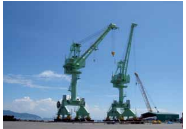
ジブクレーン（32トン・10トン）
