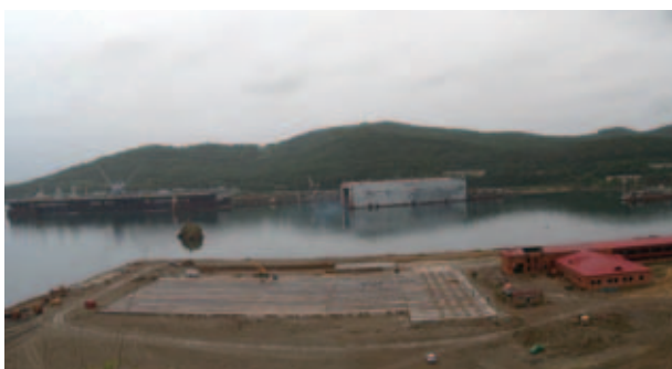
原子炉区画陸上保管施設建設現場（沿海地方ラズボイニク湾）
