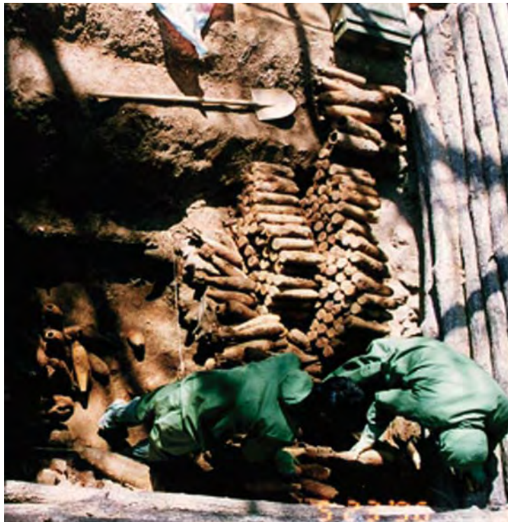
ハルバ嶺における中国 ACW の埋設風景
