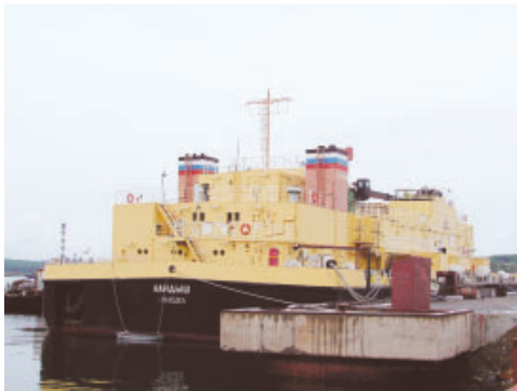
日露非核化協力の枠内で建設・供与された 低レベル液体放射性廃棄物処理施設「すずらん」
