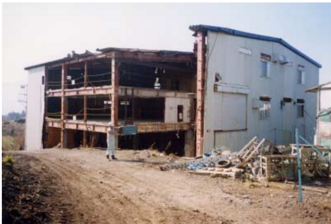
第7サティアンの解体状況
