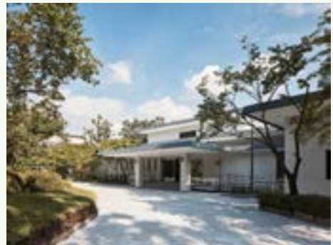
改修工事を経て甦った公邸の外観
