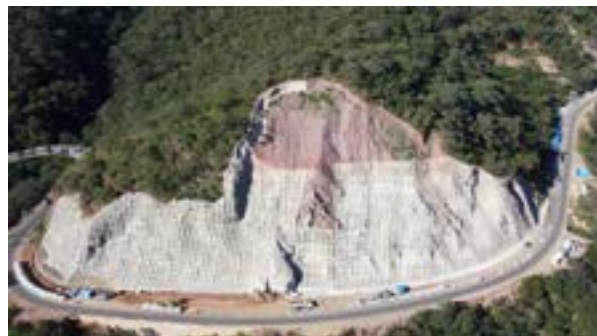
対ボリビア無償資金協力「国道7号線道路防災対策計画」による道路沿いの斜面崩壊対策や土石流対策のための防災工事の様子（6月、ボリビア・サンタクルス県）
