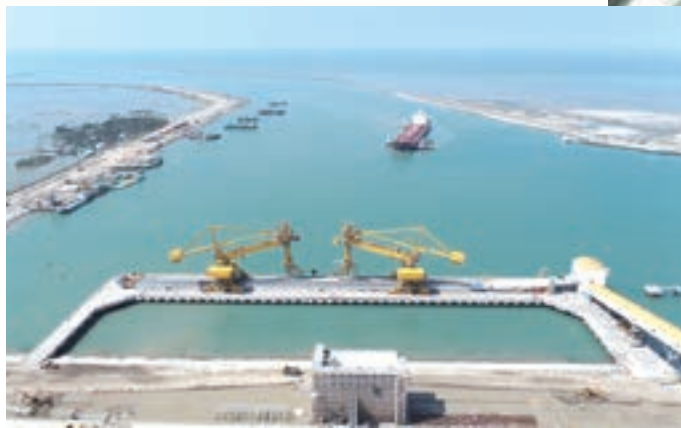
日本のPGIIの取組の例：マタバリ港開発計画の建設現場の様子（バングラデシュ・マタバリ 写真提供：バングラデシュ石炭火力発電会社）
