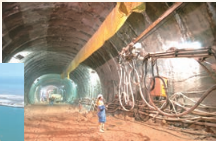
日本のPGIIの取組の例：デリー高速輸送システム建設計画における工事現場の様子（インド・デリー 写真提供：Deli Metro Rail Corporation Limited）
