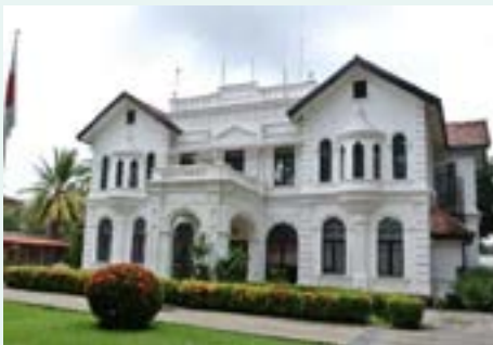
旧館棟 正面外観
