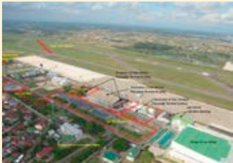
本事業の工事範囲（赤い点線が工事範囲 2014年） （写真提供：（株）安藤・間）
