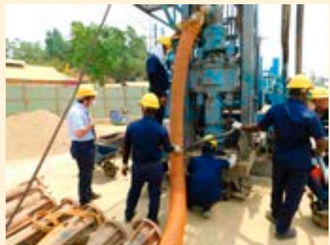
バングラデシュの避難民キャンプにおける深井戸掘削 (写真提供：JICA)
