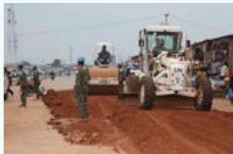
ジュバからマンガラ間の道路補修を行う自衛隊（南スーダン 写真提供：防衛省）
