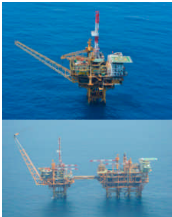
日中間線付近において設置が確認された中国の海洋プラットフォーム (写真提供：防衛省) 詳細は、 http://www.mofa.go.jp/mofaj/area/china/higashi-shina/tachiba.html 参照
