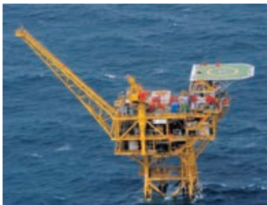
日中中間線付近において設置が確認された中国の海洋プラットフォーム (写真提供: 防衛省) 詳細は、 http://www.mofa.go.jp/mofaj/area/china/higashi-shina/tachiba.html 参照
