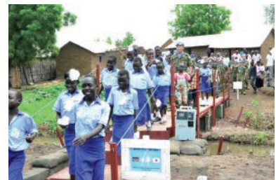
南スーダンにおいて自衛隊が設置した小学校の簡易歩道橋
