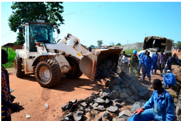
国連南スーダン共和国ミッション（UNMISS）において、日本のODA事業との連携で、首都ジュバのナバリ地区コミュニティ道路の整備を現地住民と共同で行う自衛隊施設部隊（南スーダン 写真提供：防衛省）
