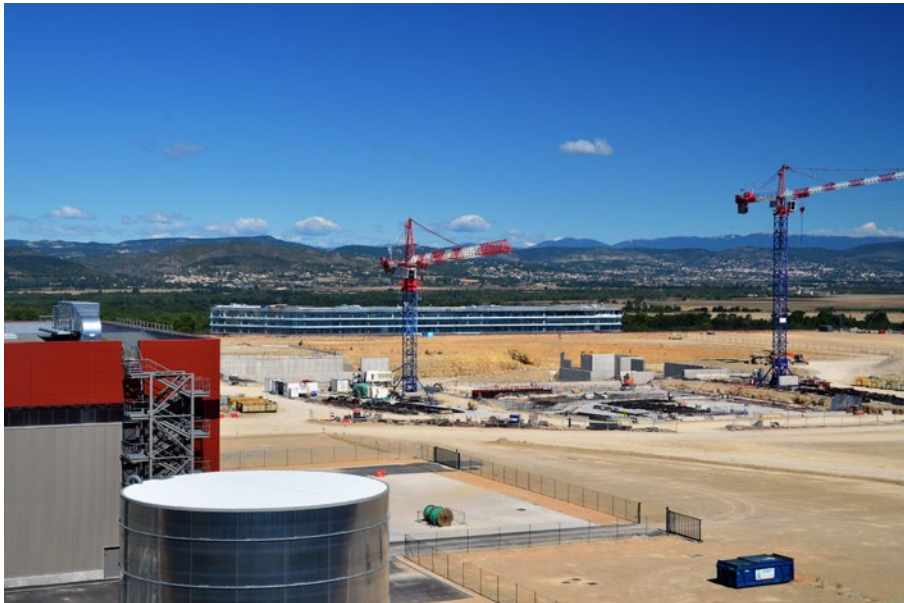
建設中のイーター実験炉（写真提供：Credit@ITER Organization, http://www.iter.org/ ）
