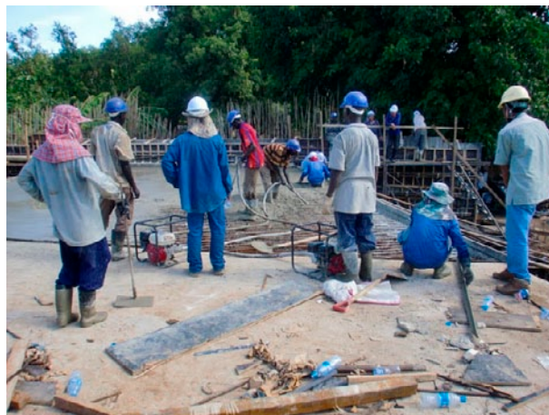
ジュバ道路橋梁整備計画（南スーダン 写真提供：日本国際協力システム）
