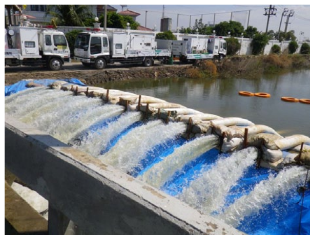
タイの洪水に際し、日本から派遣された国際緊急援助隊排水ポンプ車チームによる排水活動の様子（タイ）
