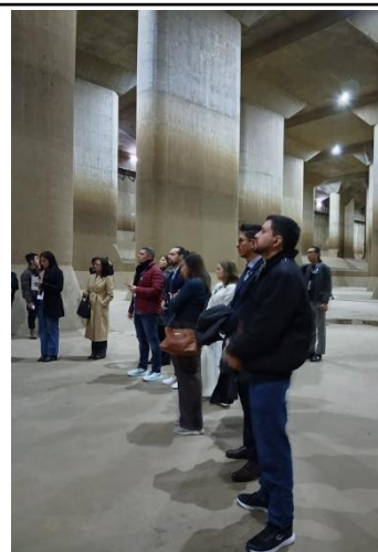
3月7日 首都圏外郭放水路
