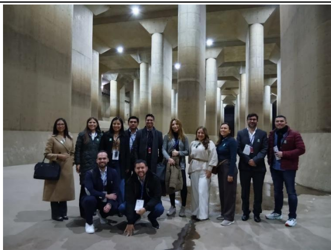
3月7日 首都圏外郭放水路
