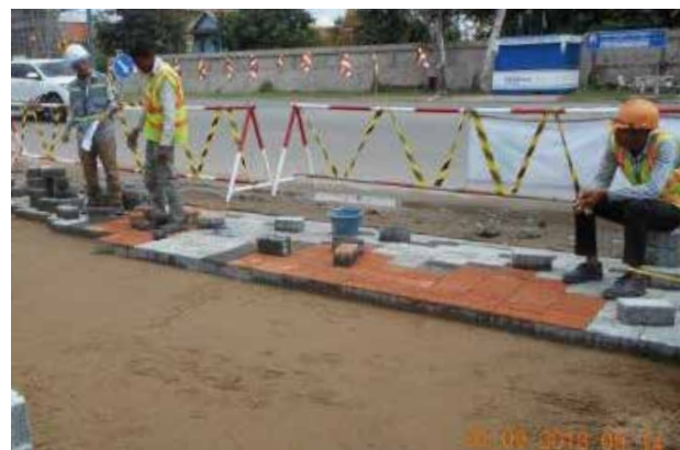
舗装作業では現地建設会社への実務研修も行い、道路建設ノウハウの伝承にも努めた。
