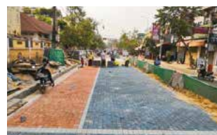
シェムリアップ州病院前道路の施工の様子。未舗装の路面に下地となる砂を敷き、端からILBを並べていく。
