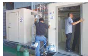
普及・実証事業で納品したフロン再生装置。JICAマレーシア事務所の確認を経て本格稼働となった。
