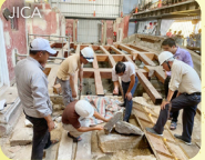
ホイアン日本橋の修復作業
