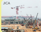
建設工事はIHインフラシステム・三井住友建設の共同企業が担当
