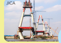
2015年に開通したニャットン橋工事の様子
