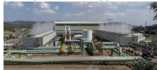
Centrale électrique géothermique d'Olkaria I Unité 4 et 5 (Photo : Agence japonaise de coopération internationale)
