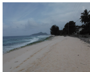
2014年1月の養浜後の海岸(写真: JICA) 北東部における、養浜による海岸浸食対策パイロット・プロジェクト
