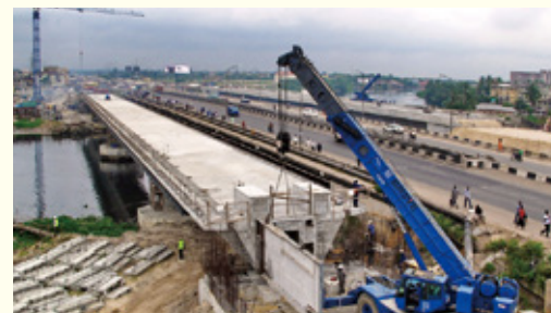
PIDA: Estrada Lagos-Abidjan em Gana
