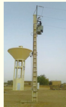
Château d'eau et poteau électrique, Sénégal
