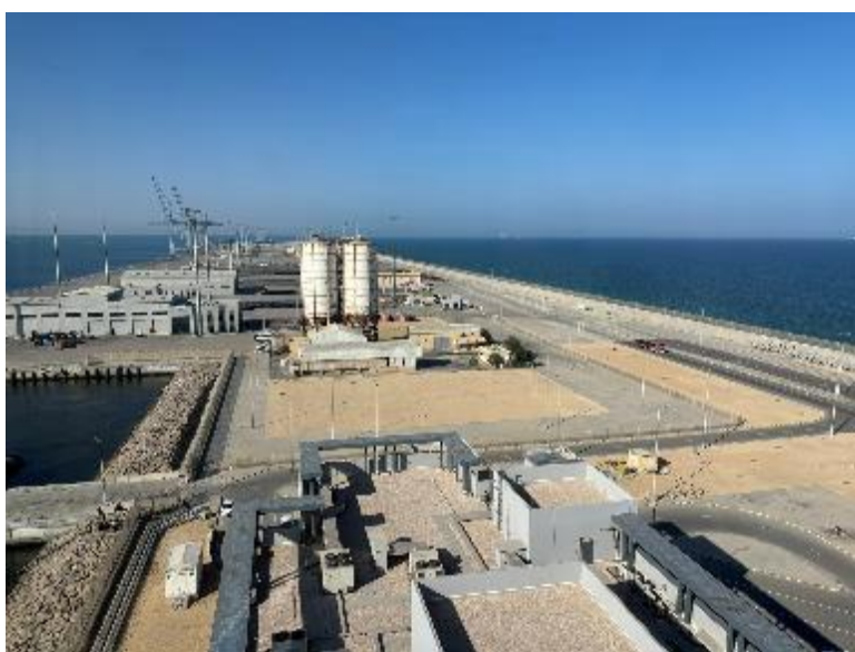
（建設中のドゥクム港湾施設の一角）
