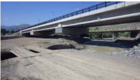
タラスータラズ道路ウルマル川橋梁架け替え計画 (6月、キルギス・タラス州 写真提供：JICA)
