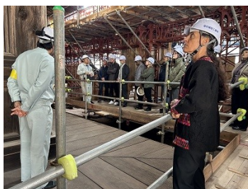
瑠璃光寺五重塔改修工事現場にて作業員の説明を聞く各国の駐日大使ら
