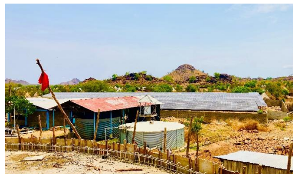
図 11：ガンベラでの太陽光サイト
