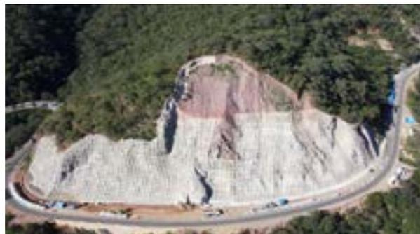
対ボリビア無償資金協力「国道7号線道路防災対策計画」による道路沿いの斜面崩壊対策や土石流対策のための防災工事の様子（6月、ボリビア・サンタクルス県）
