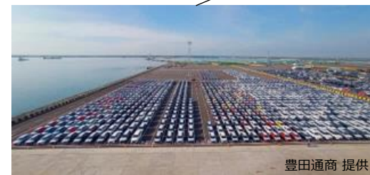
自動車ターミナルの状況
