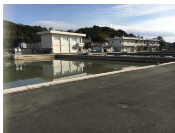
小鷹野浄水場
