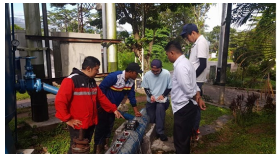
ビダダリ配水池:ダマール配水池送水流量測定
