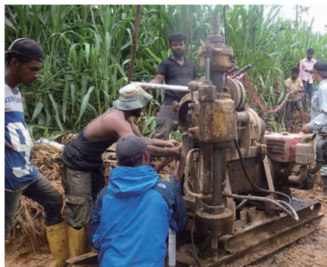
事業実施のためのボーリング工事は、現地業者との協業により行った。
