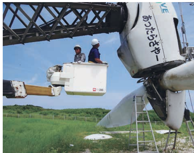
波照間島（八重山郡竹富町）での実機研修では、稼働中の風車を活用してのレクチャーを行った。
