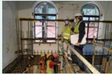
工事現場での施工者との協議（筆者右）
