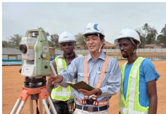
ギニア人職員に測量を教える日本人職員 (セントラルコンサルタント・大日本土木提供)
