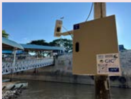
日本の援助と現地政府の協力で設置されたCCTV監視カメラ。映像はAIを使って分析
