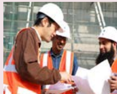
工事現場での施工業者との打合せ風景
