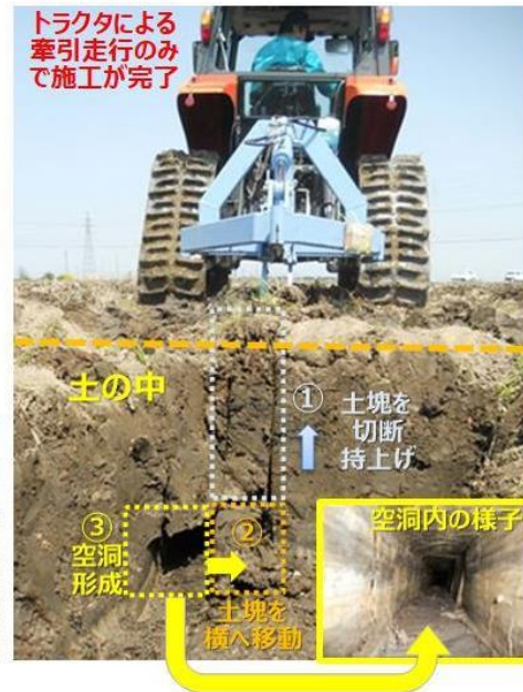
写真3 穿孔暗渠施工の原理
