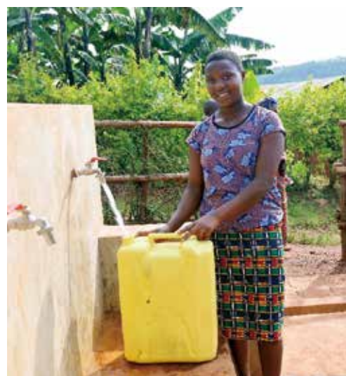
村に建設した水くみ場。 住民の水利用組合が維持管理
